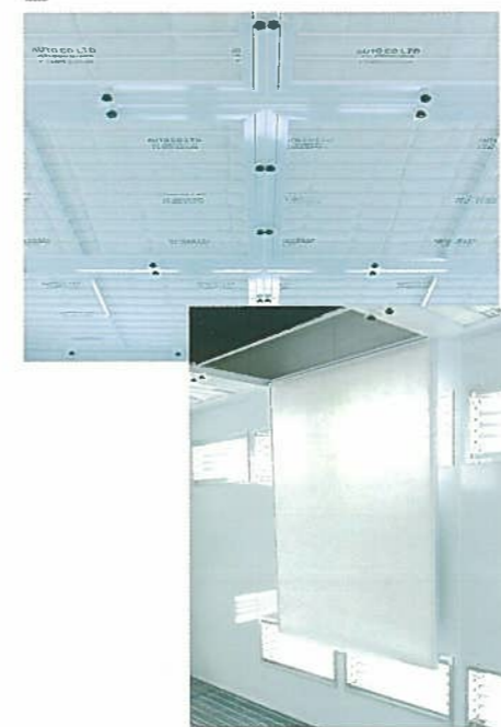
天井フィルターは一人でも交換可能。手間のかかるフィルターメンテナンスの煩わしさを解消。
