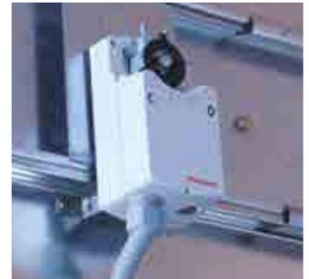
操作盤と連動し、排気ダクト内のダンパーを操作盤からリモートコントロール。
