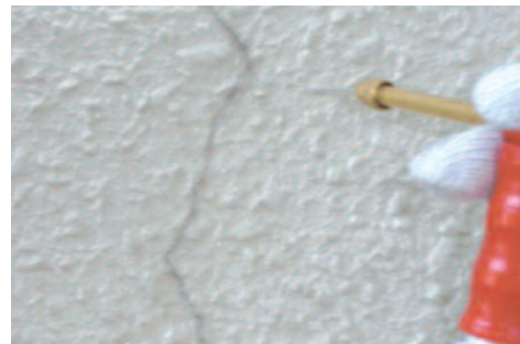
ひび割れ内部を高圧洗浄
