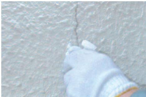
注入充填後、ふきとり清掃仕上げ
