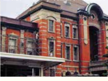
■ 築後80年レンガ外壁防水・防湿工事
