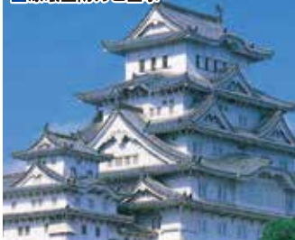
■ 漆喰壁防カビ工事
